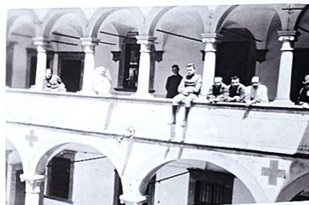
Le doppie arcate della villa (ribassate quelle inferiori e a tutto sesto quelle superiori) nella fase operativa dell'ospedale
