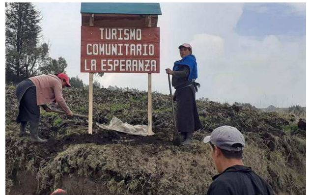
Collocazione di nuova segnaletica
